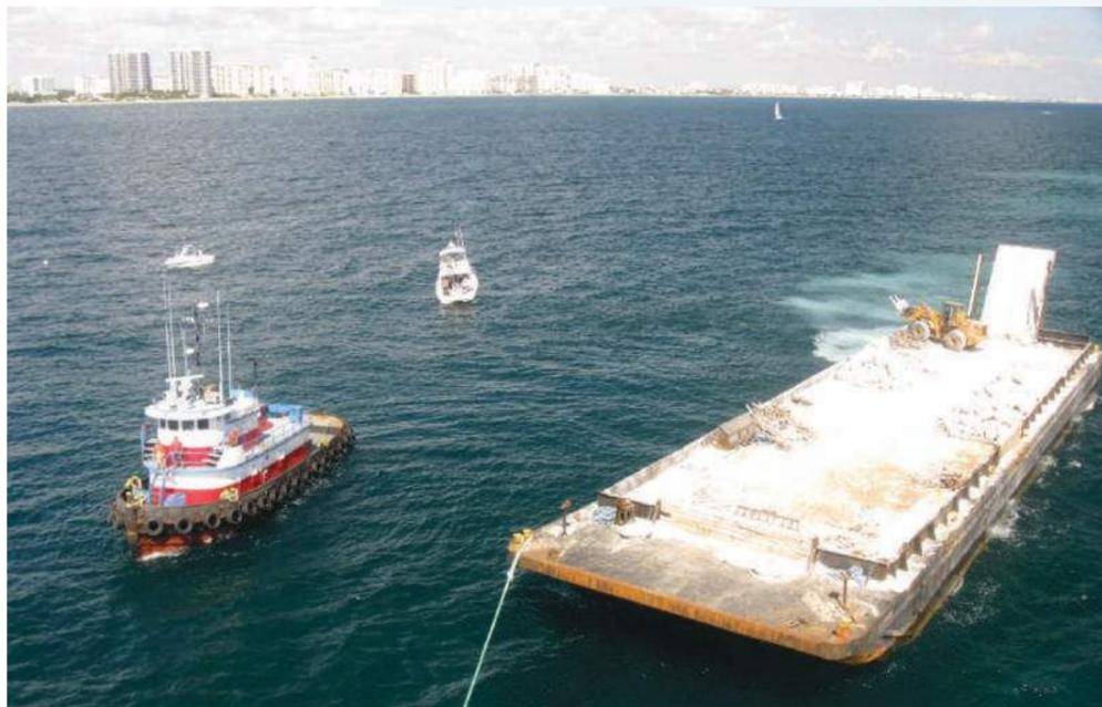
Figure 1 : Immersion de récifs artificiels constitués de blocs de roches calcaires pour compenser la dégradation des bancs coralliens en Floride
