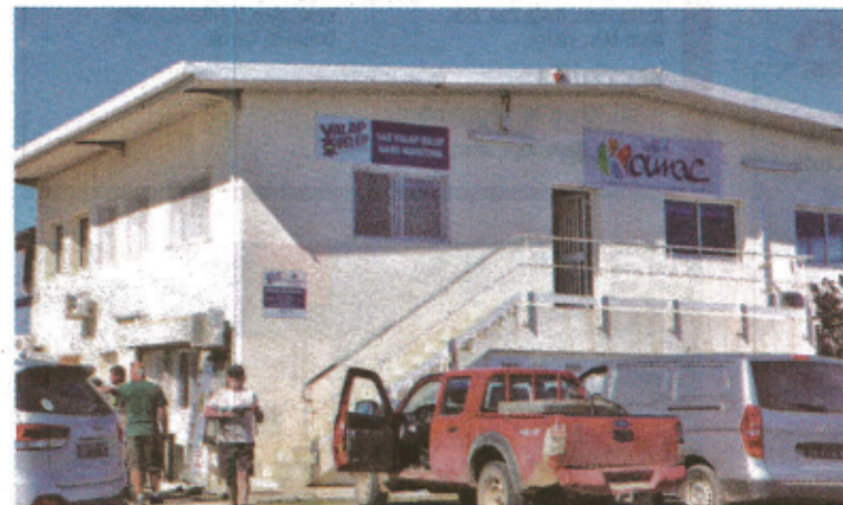
Une grande partie de la toiture a été changée et le réseau électrique a également été refait.
